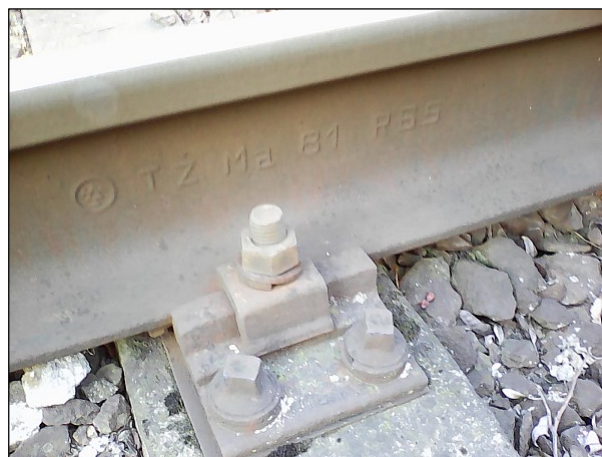
Detail železničního svršku – propojka (3. kolej)
